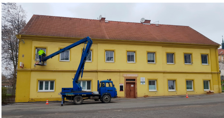
Instalace zábran proti hnízdění na obecní budově hostince U Tří lip.
