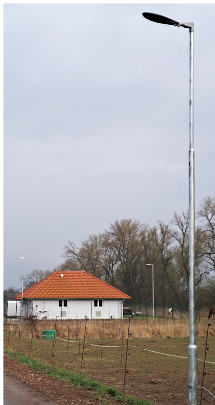
Nové osvětlení na ČOV.
