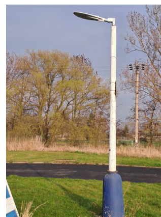
Rekonstrukce veřejného osvětlení u benzínové čerpací stanice.
